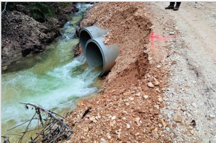
Slika 2. Sanirana dionica puta oštećena bujičnim tokom
