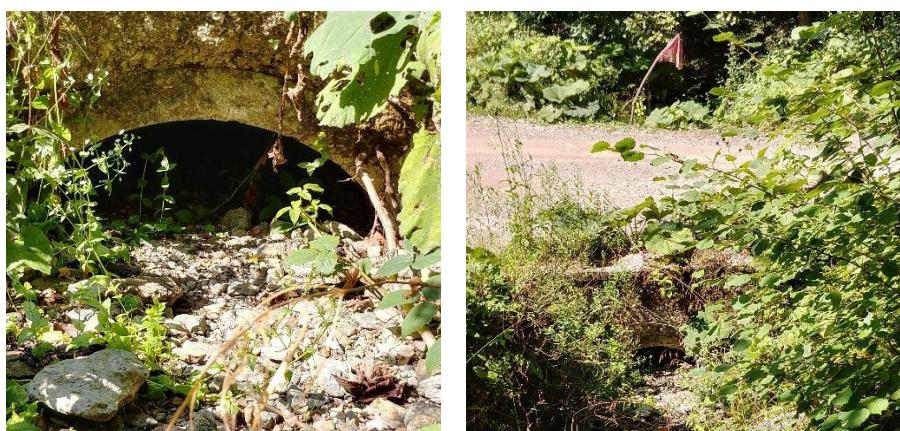
Slika 18. Cjevasti propusti u potpunosti ili djelmično zatrpani erodiranim materijalom (M. Bajrić, 2017)
