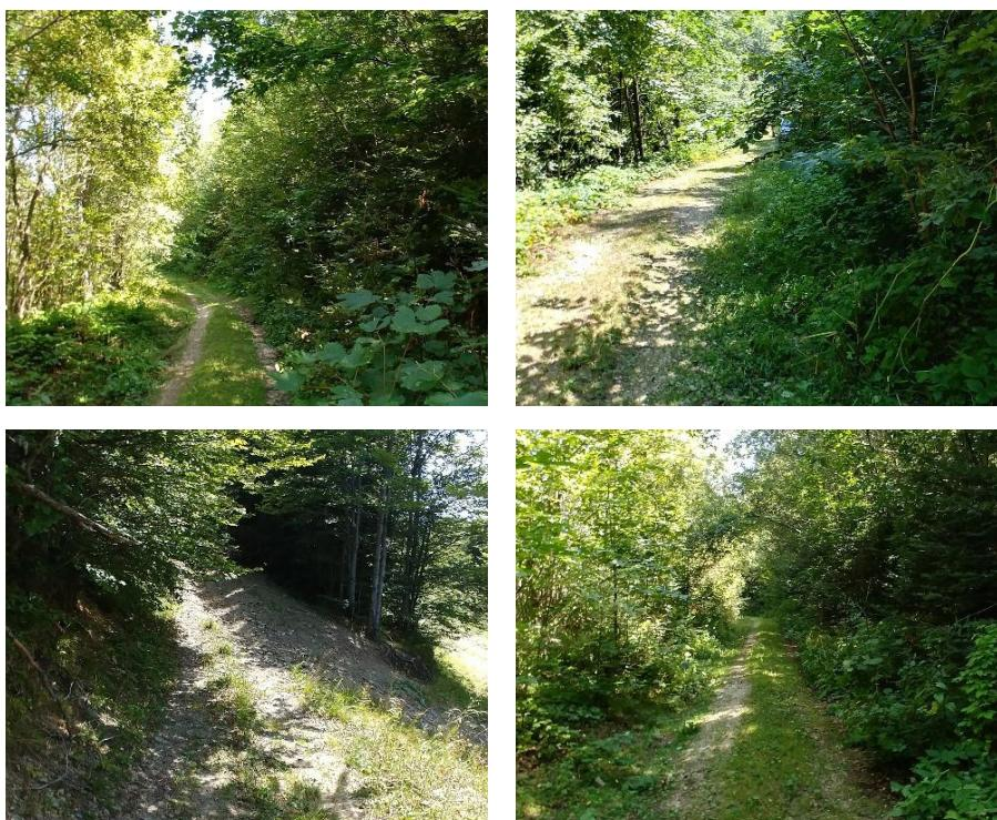
Slika 20. Zatrpani i obrasli odvodni jaci za odvodnju površinskih i oborinskih voda (M. Bajrić, 2017)
