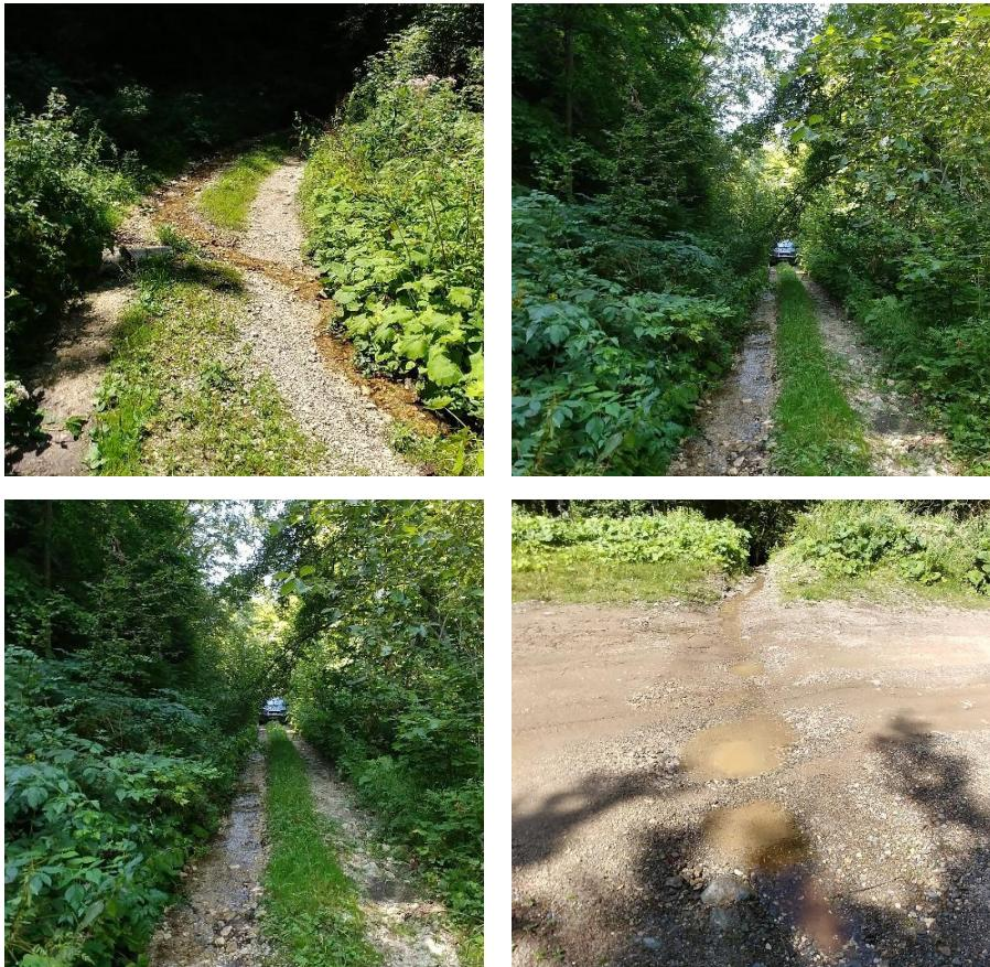
Slika 22. Površinsko oticanje vode po kolovoznoj konstrukciji (M. Bajrić, 2017)
