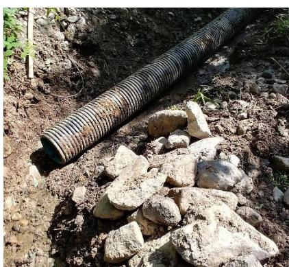
Slika 26. Rebraste plastične cijevi kao privremeni vodopropusni objekat na sekundarnoj mreži (M. Bajrić, 2017)
