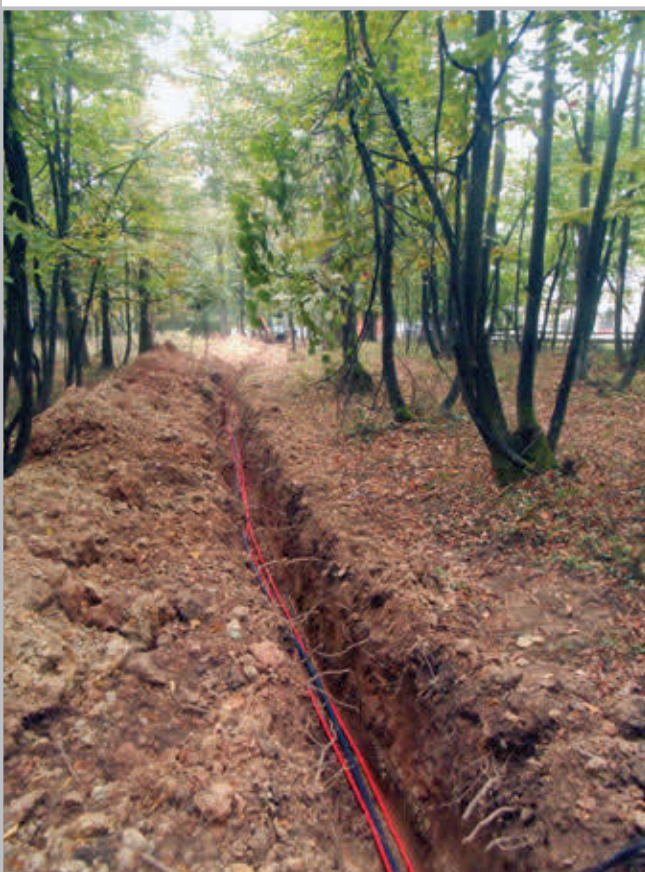
Slika 2. Infrastrukturni radovi u Park šumi
