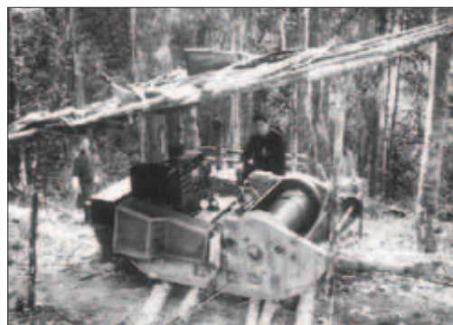
Slika 2. Pogon žičare za srednje udaljenosti (300 - 900 m) Figure 2. Forest skylines driving for medium distances (300 - 900 m)
