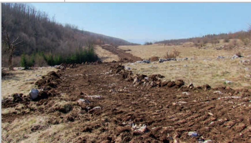
Slika 6. Zapažen angažman ŠPD-a na izgradnji i rekonstrukciji šumskih puteva
