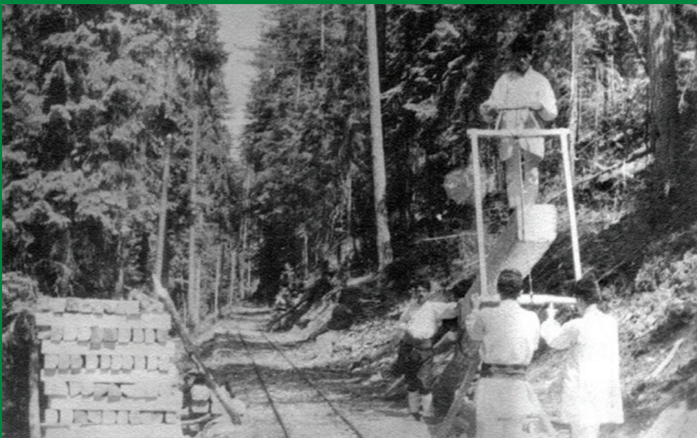
Slika 2. Han Pijesak: Izrada željezničkih pragova ručnom pilom
