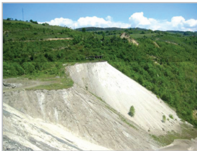
Slika 5. Deponija šljake i pepela Termoelektrane Kakanj na lokalitetu Turbići, izvor : Glavni projekat Rudarski institut Tuzla (2008)
