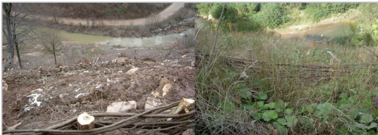
Slika 2. (lijevo) Predstavlja tek postavljene pletere od pruća u 2005. god., (desno) predstavlja pletere pruća koji stabiliziraju podlogu i omogućavaju rast i razvoj posađenom autohtonom sadnom materijalu (2007.)
